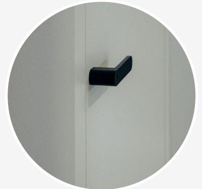
► Detail: Flächenbündigkeit von Wand, Zarge und Türblatt
